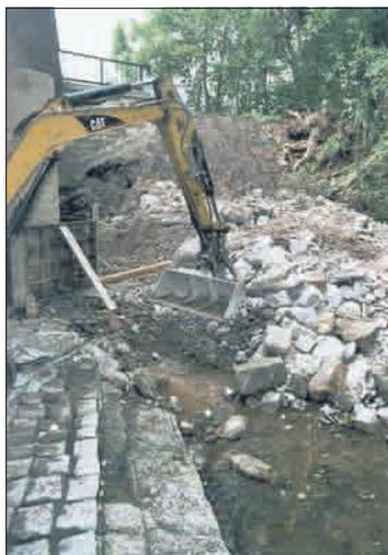
Bei der Sanierung der Fahrbrücke gehen die Bautätigkeiten des ersten Bauabschnittes (Sanierung der Pfeiler und Widerlager, Regulierung des Flusslaufes und Beschichtung des Brückentroges) ihrer Vollendung entgegen.
