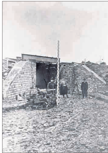
Bau der EÜ Frankenthal um 1910
