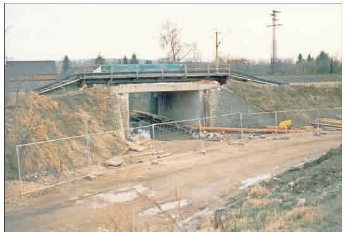
Ausbau der EÜ Frankenthal 1997
