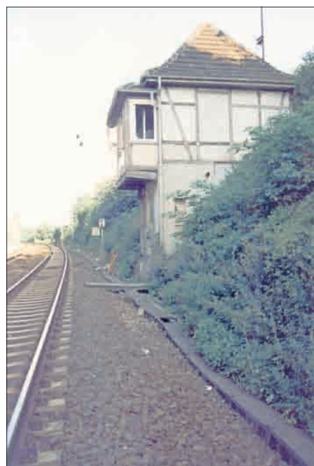
Blockstelle Marienthal vor dem Abriss 1996
