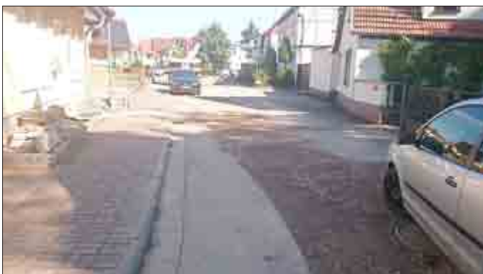
Neue Straße Neu
