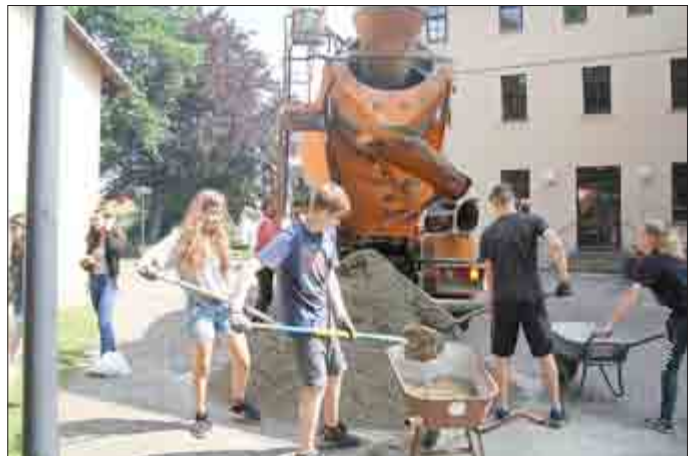
Wir verarbeiten 3 Kubikmeter Fertigbeton aus Thörey
