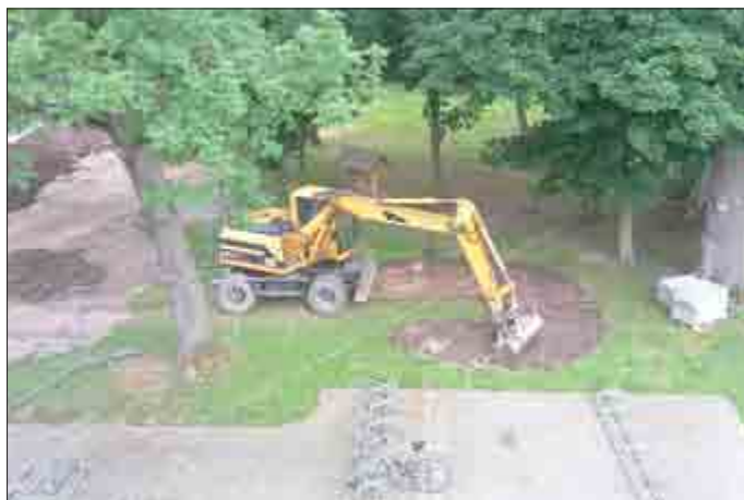
05.06.18 - Mittags rückt der Bagger an.
