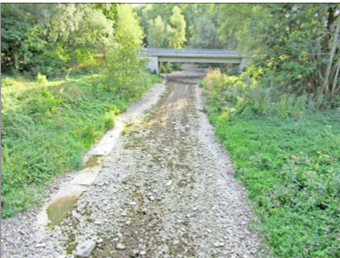
Blick von der Marienthalbrücke zur Straßenbrücke
