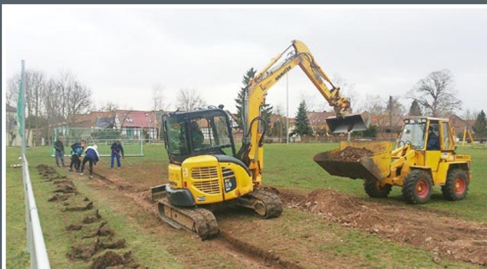
Der Bau des Brunnens samt Anschlussleitungsnetz für die dauerhafte Beregnung des Sportgeländes in Apfelstädt konnte abgeschlossen werden. Lesen Sie mehr dazu unter:
